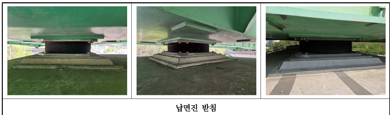
【사진 26.3.13】 교량받침 전경
