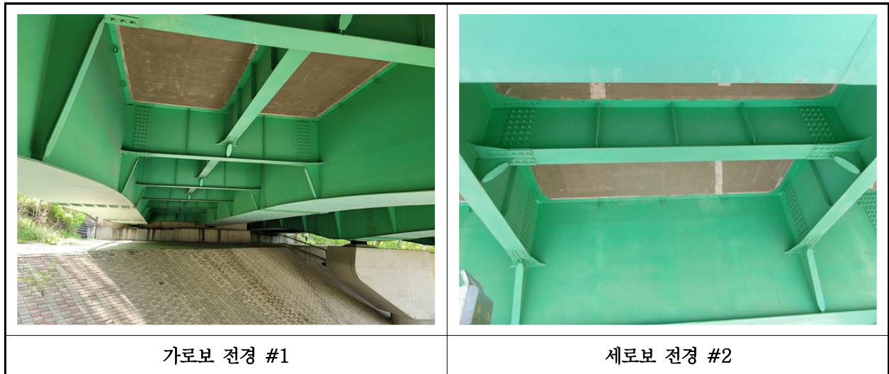
【사진 26.3.6】 가로보 전경
