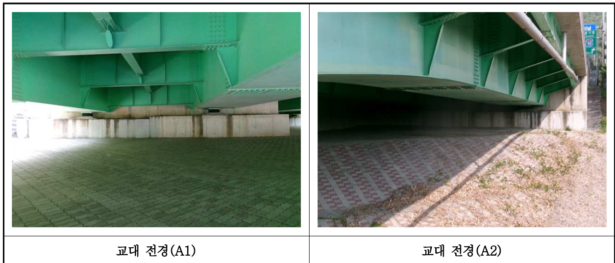
【사진 26.3.8】 교대 전경
